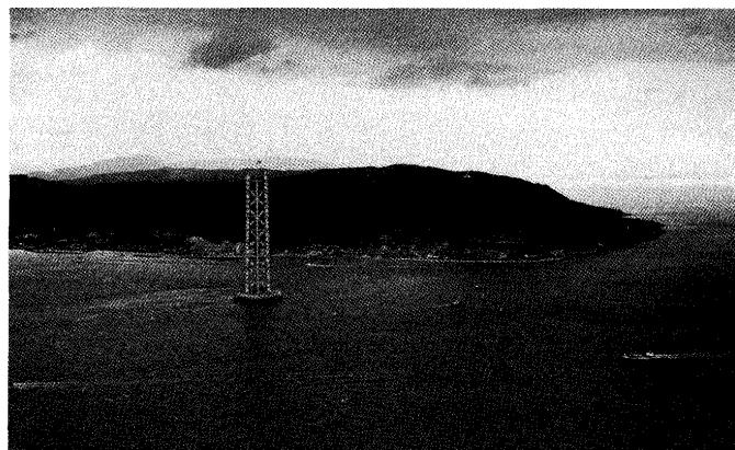
2P塔頂部より3Pおよび淡路島を望む。3Pは2Pより約2か月遅れて完成する予定であり、最後のX字を架設しているところである。(1993年3月18日撮影)
