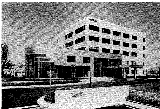
鉄鋼技術研究所本館全景
