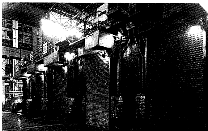
写真 私の初仕事である完全連続ミル（圧延機の囲りからオペレーターを一掃した：NKK福山2 TCM）
