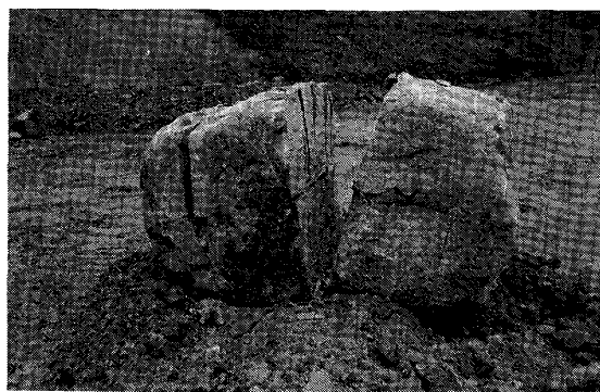
写真9 静的破碎剤による転石の破碎
