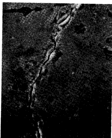
写真1. 42% MgCl 2 中C3試片の裏側にみられる応力腐食割れ
