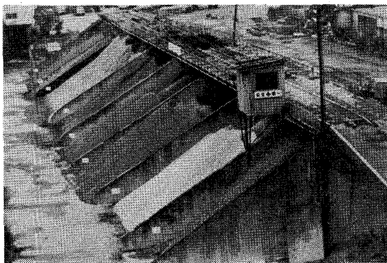
写真1 レーダーミクストコンクリート工場における骨材置場の一例
