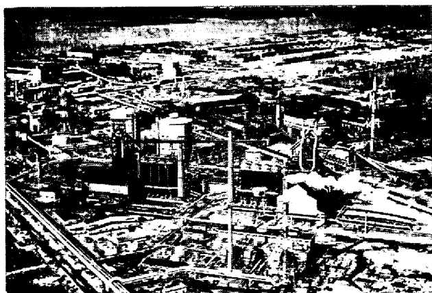
写真 1 水島製鉄所の全景
