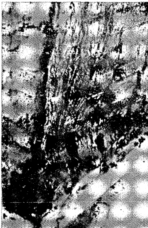
写真2 レキュペレータ室側壁レンガの熔融
