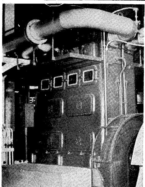
日鋼スルサー無給油圧縮機は潤滑油が不要で、完全に清浄な酸素ガスを、爆発や火災の危険なしに、お望みの圧力で供給します。
